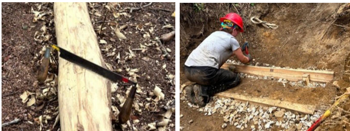
(ルートボール (施工前、左) と施工後 (右))
