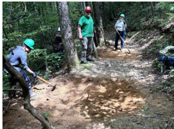
(排水工法の施工風景)
