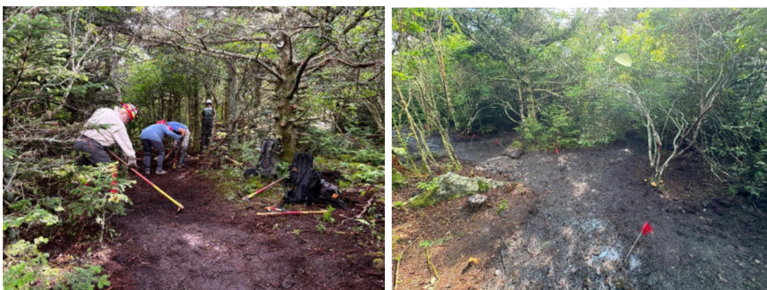
(トレッドを整地する。トレイルは左奥へと続くが、水は右奥へ流れるようにするよう、トレッドに高低差を設けている(左))
