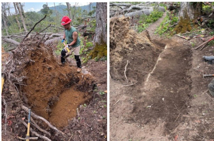
(ルートボール (施工前、左) と施工後 (右))
