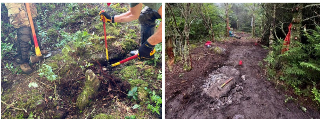
(根や石は除去もしくは再配置され、安定したトレッドを構築)
