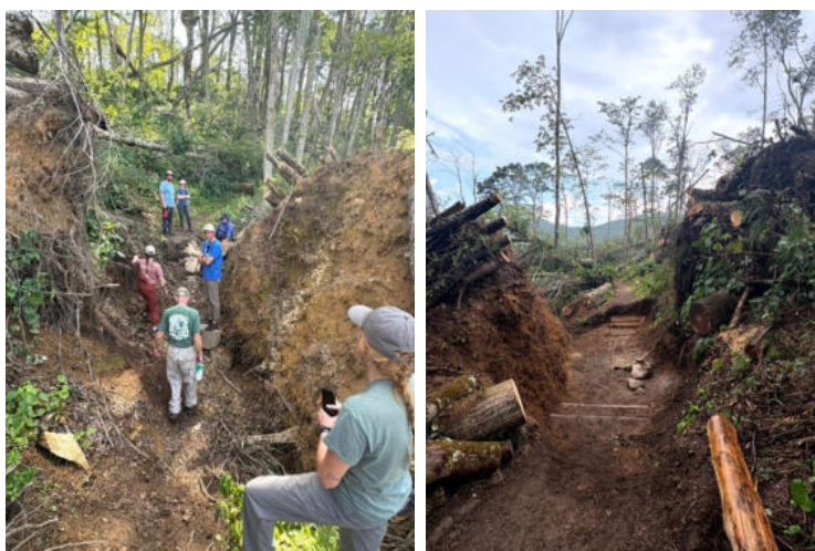
(ルートボール (施工前、左) と施工後 (右))
